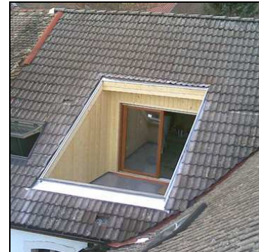
Défoncé de toiture
