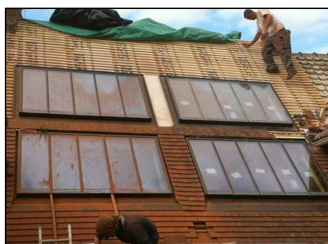
Batterie de châssis de toiture
