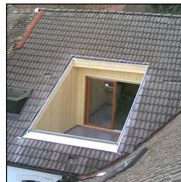
Défoncé de toiture
