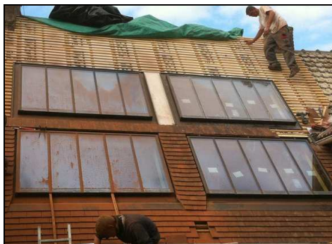
Batterie de châssis de toiture
