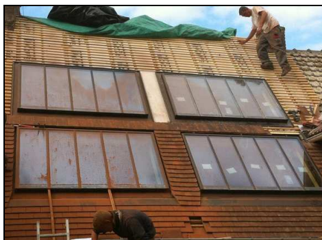
Batterie de châssis de toiture
